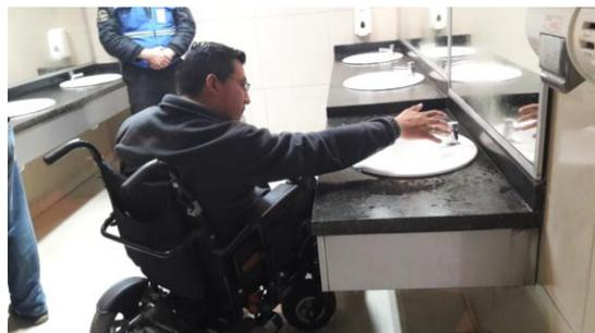
MESÓN CORRIDO DE LAVABOS CON DISEÑO A DOBLE ALTURA Y ESPEJO BAJO
