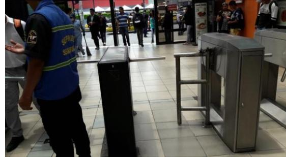
DETALLE DE EQUIPOS DE CONTROL TORNO, BRAZO QUE CAE Y EQUIPO ADAPTADO
