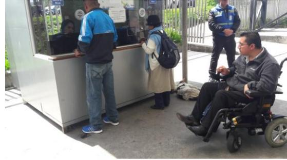
DISEÑO DE BOLETERÍA CON DOBLE VENTANILLA A UNA SOLA ALTURA DE MESÓN Y PASAVOZ
